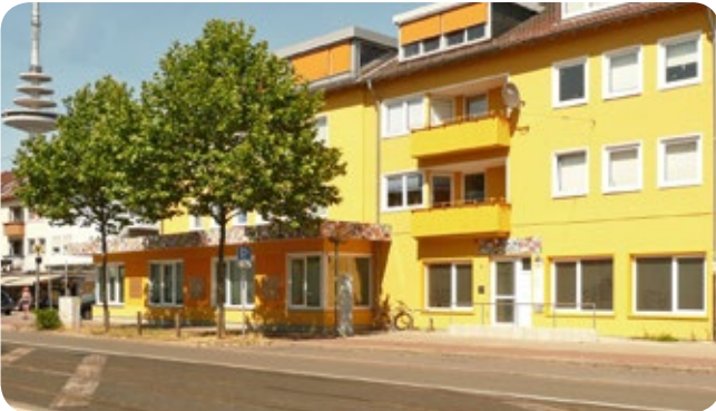
Die Frühförderstelle in der Landwehrstraße in Bremen-Walle
