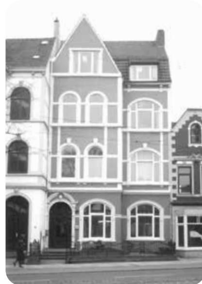
Vor dem Abriss der Hausnummer 53 (ganz rechts im Bild).
